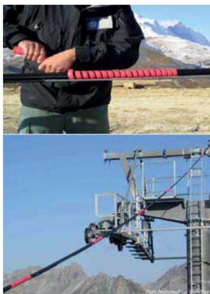
Figura 13: dispositivo di segnalazione montato in Francia sul cavo multicoppia delle seggiovie (foto: OGM - Observatoire des Galliformes de Montagne)
